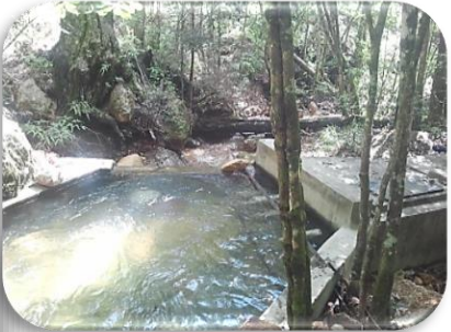
OBRA DE CAPTACION
