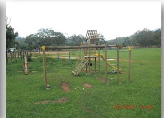
Construcción parque infantil
