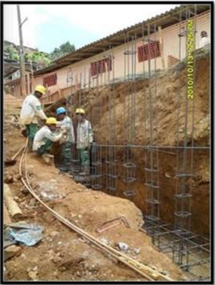
Muros de contención
