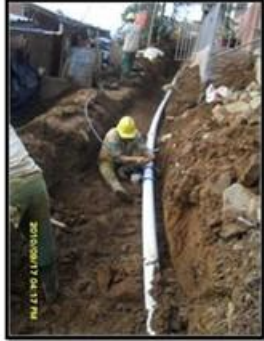
Instalación de redes de acueducto y alcantarillado
