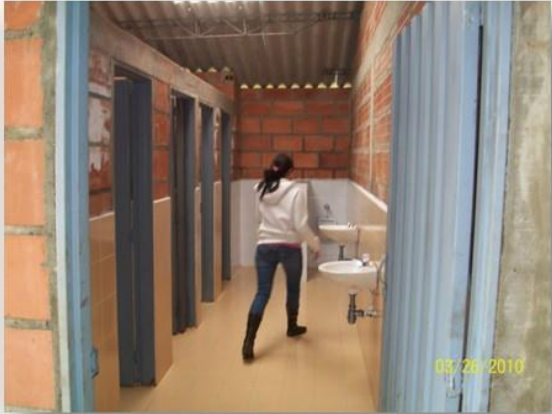
Construcción de baños y adecuación de baterías sanitarias
