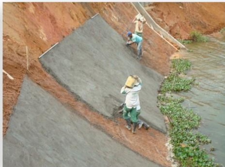
Recubrimiento en malla y mortero
