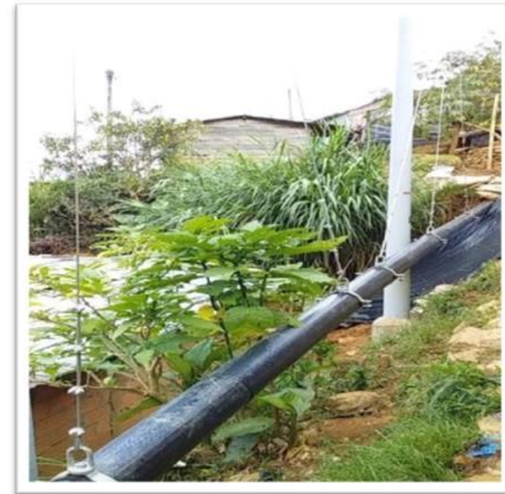
Alcantarillado La Honda – Comuna 3 Viviendas conectadas: 166 Longitud: 30 metros
