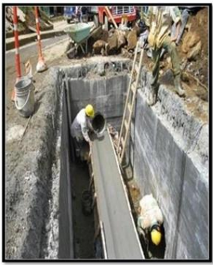
Construcción de Manholes, sumideros y aliviaderos
