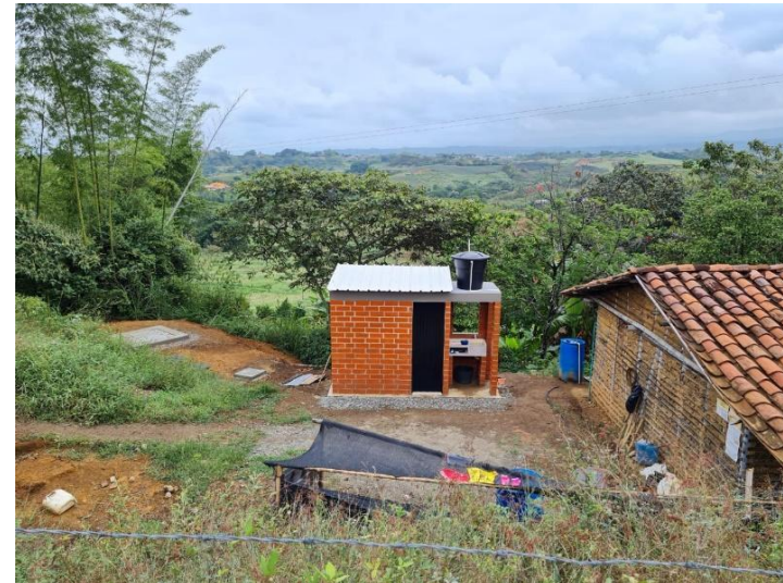
Viviendas no conectadas a alcantarillado Tratamiento de vertimientos
