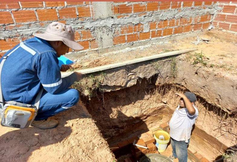
Apoyo técnico en la mejora y construcción de cámaras sépticas y sistemas de infiltración
